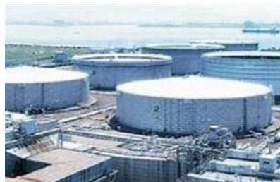
石油貯蔵タンク
