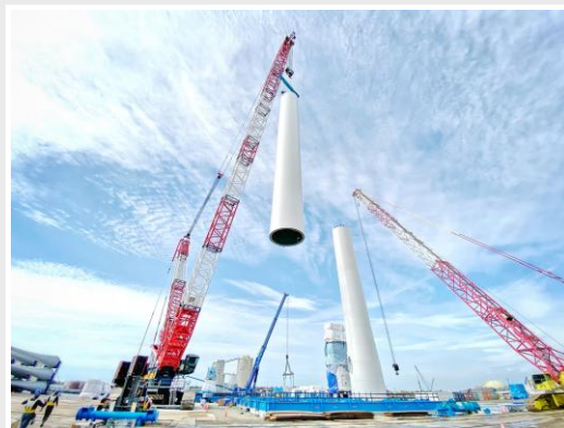
クレーン（洋上風車組み立て）
