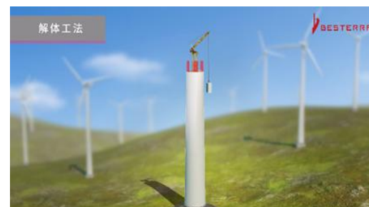
タワークレーン工法
