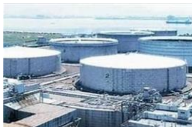
石油貯蔵タンク
