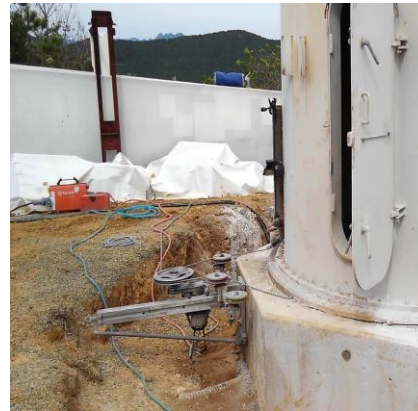
ワイヤーソーイング工法
