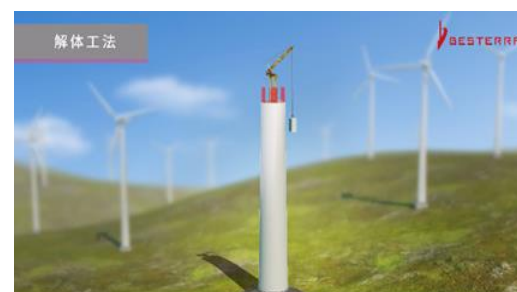
タワークレーン工法
