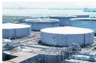
石油貯蔵タンク
